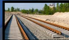
RIGI: Incorporan obras de ampliación de infraestructura ferroviaria
